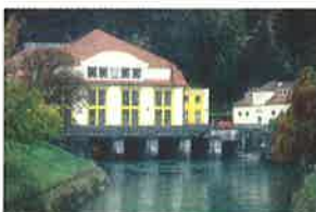
Kraftwerk Kibling in Bad Reichenhall
