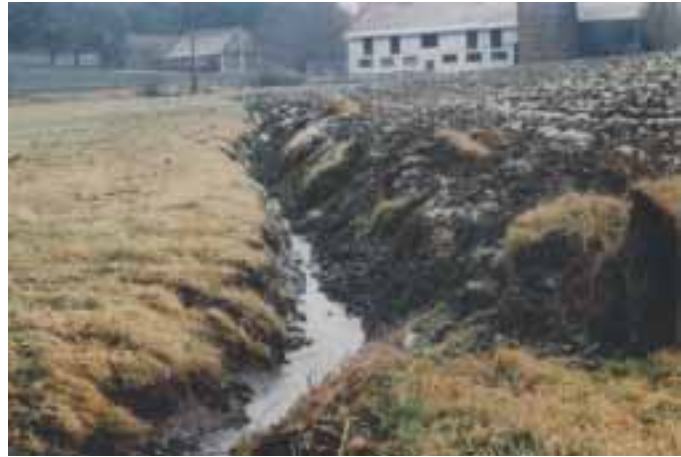
Foto 15: (zu Kap. 4.2.2.1.2). Vorbildliches Ergebnis einer Grabenräumung mit einem Bagger bei Wartenberg/ED: hohe Strukturdiversität und geringe Sohleneintiefung; allerdings fehlt auf der rechten Seite ein Grünlandpufferstreifen (Foto: RINGLER 1988).
