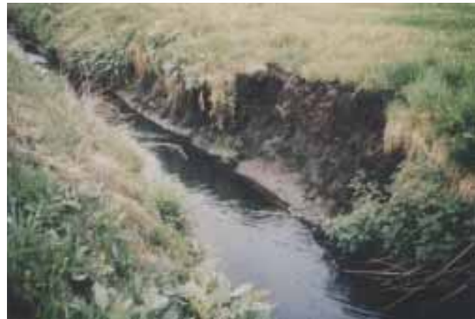
Foto 16: (zu Kap. 4.2.2.1.2): Anbruch einer durch Räumung entstandenen sehr steilen Böschung in den Loisach-Kochelseemooren/TÖL (Foto: RINGLER 5/1988).
