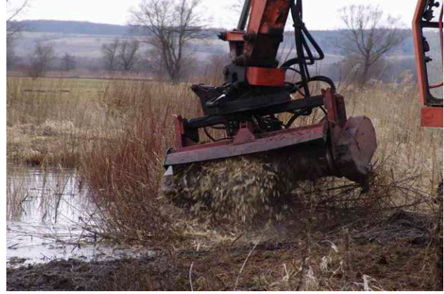
24 Grabenentbuschung mit dem Forstmulchgerät am Baggerausleger (M. KÖNGISDORFER)
