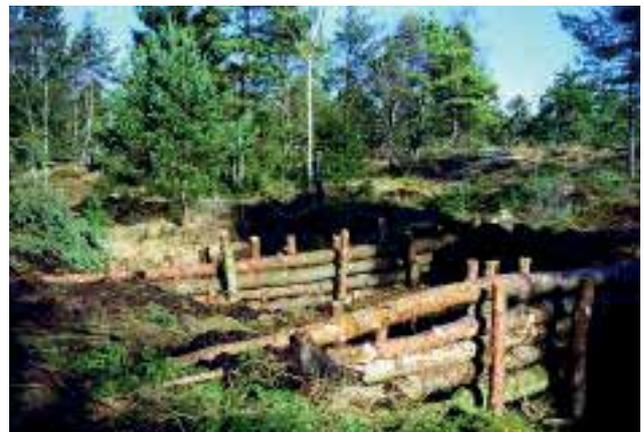
**Bild 4:** Enddämme benötigen wegen des hohen einseitigen Wasserdrucks eine doppelte Holzpalisade als Stützkonstruktion: Damberger Filzen 2002
