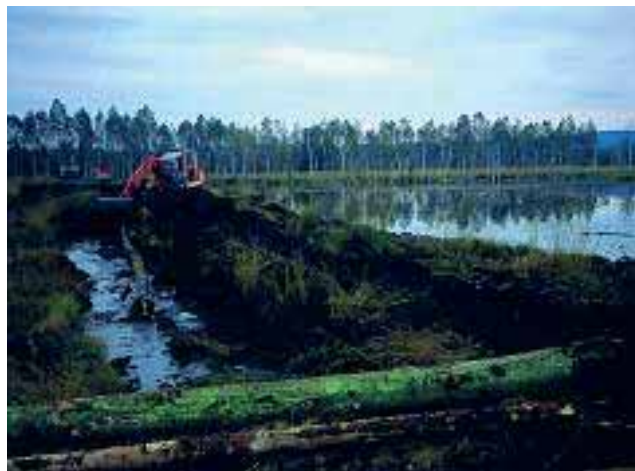
Bild 5: Der Enddamm des Egelseegrabens wurde nach unerwartet starker Torfsetzung in der Dammschüttung nachträglich verstärkt. (Hinter dem Bagger die für den Torftransport benötigte Moorraupe)
