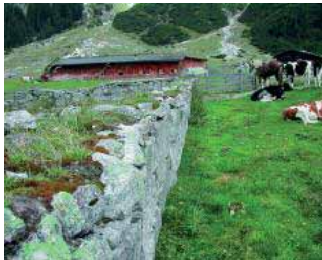
Abbildung 3: Die Erhaltung dieses Steinhags erfordert jährliche Wartungsarbeiten
