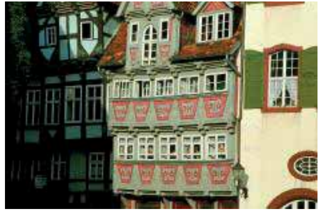
Abbildung 8: Traditionelle Bausubstanz als Stolz einer Stadt, hier Quedlinburg
