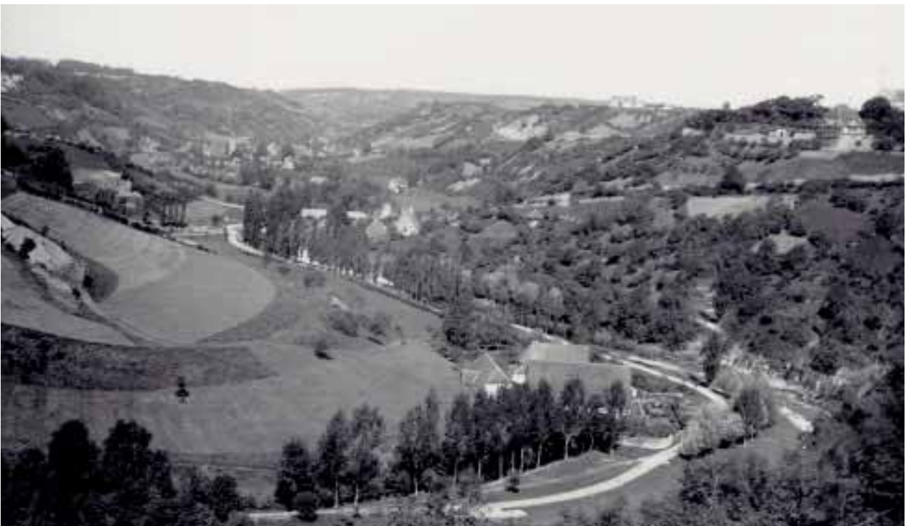
Abbildung 2: Historische Aufnahme von dem oberen Taubertal zwischen Rothenburg o.d.T. und Detwang an der Wende zum 20. Jahrhundert. Deutlich erkennbar sind die Lesesteinriegel als Zeugnisse des historischen Weinbaus. Fotosammlung Schreyer, Rothenburg o.d.T.
