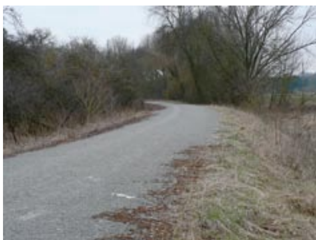
Abbildung 3: Radweg auf einem ehemaligen Bahndamm nördlich der Stadt Seßlach im Landkreis Coburg mit gut verdichteter Feinsplittdecke.
