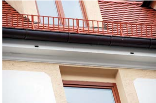
Abb. 4: Individuell gestaltete Quartiere im Dachrandbereich, hier für Mauersegler und Haussperlinge, schaffen auch an denkmalgeschützten Bauten unauffällig Brutraum für Gebäudebrüter (Foto: Sylvia Weber).
