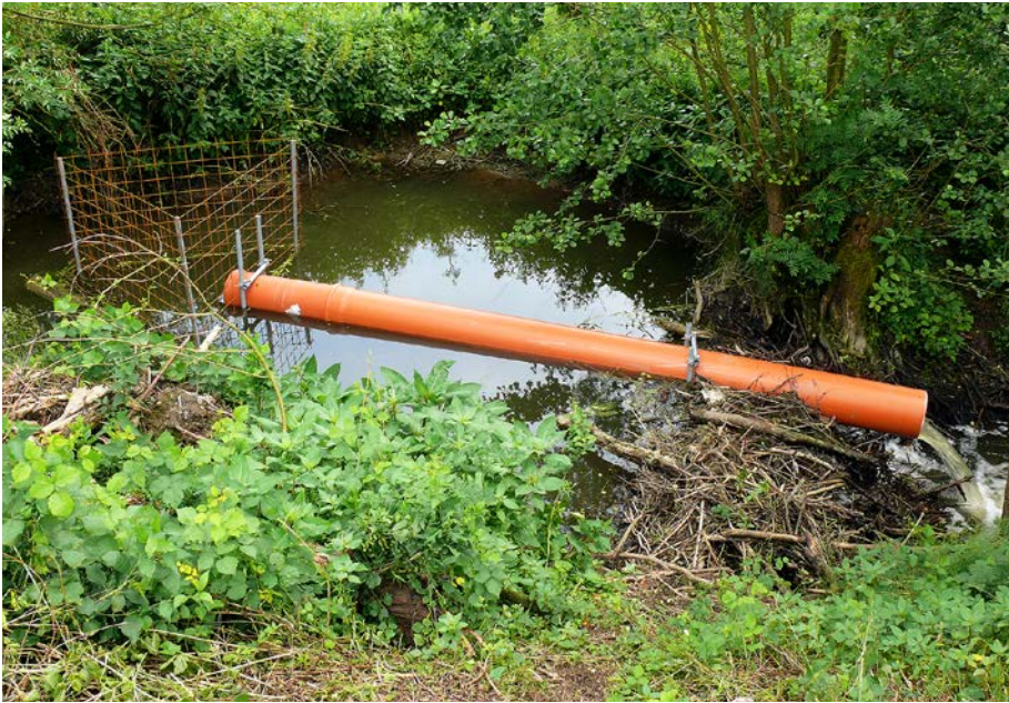
Abb. 3: Eine Dammdrainage senkt den Wasserspiegel auf ein für den Biber und den Landwirt akzeptables Niveau (Foto: Gerhard Schwab).
