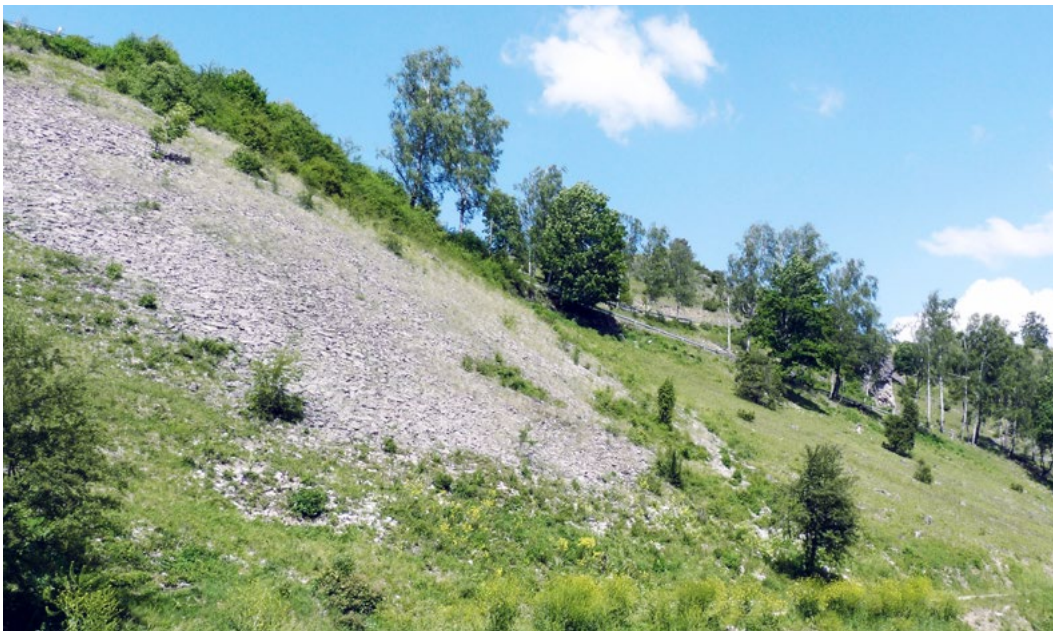
Abbildung 6 Straßensstützhang heute mit angrenzenden, beweideten Trockenhängen auf beiden Seiten des Hanges (hier: Ostseite; Foto: Adi Geyer).
