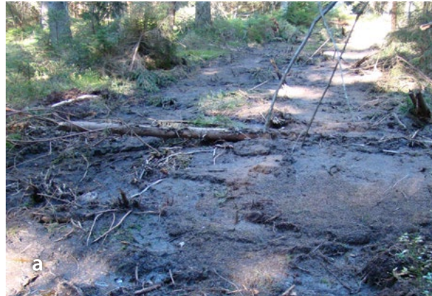
Abbildung 10 a) Entwässerungsgraben im Fichtelseemoor direkt nach der Verfüllung (Foto: Manfred Scheidler)
