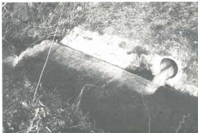
5: »Abwasserfahne« des Überlaufes der Kläranlage Oberhinkofen.
