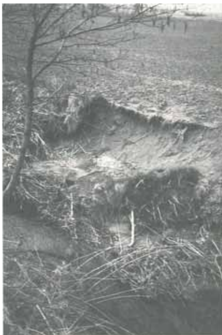
3 (links): Uferabbruch (Aubach) westlich von Burgweinting.
