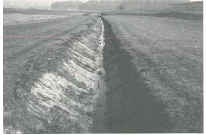
2: »Bachräumung« im Bereich des Aubachoberlaufes südlich von Neudorf.
