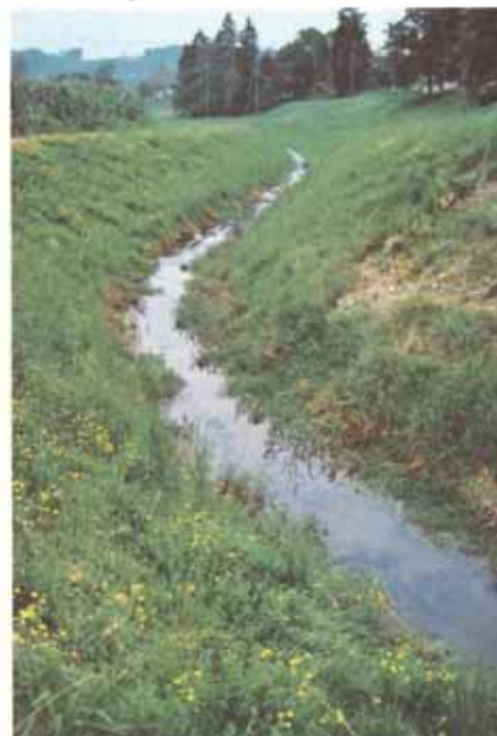
b) Rasengitterstein; 1976 nur Rasengitterstein inkl. Sohle, 1977 ähnliches Beispiel aber mit Betonsohle. (Photo E. KESSLER*)
