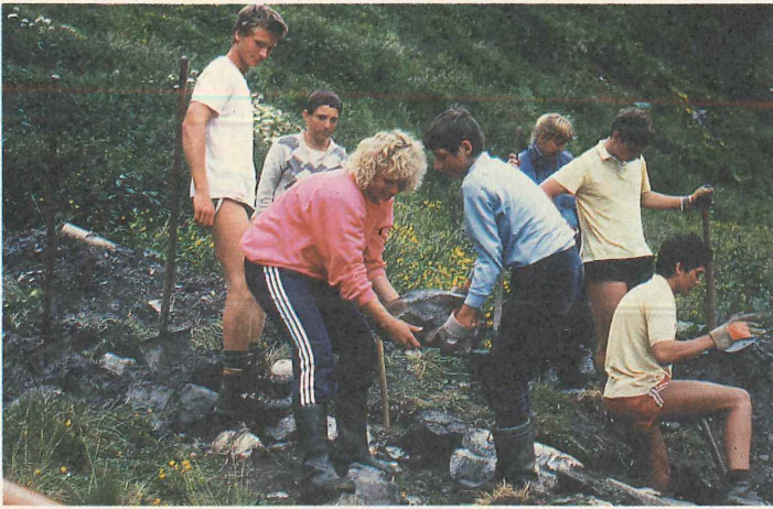
Abbildung 2 Bau einer Sandfilter-Kläranlage (Stickerhütte)
