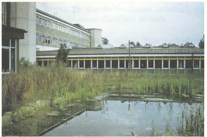
7 Ehrenbürg-Gymnasium, Forchheim, Regenrückhaltebecken.
