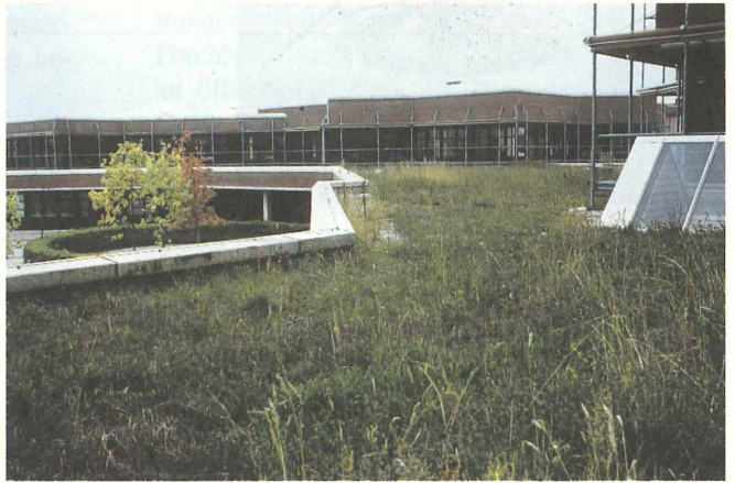
6 Europäische Schule, München, extensive Dachbegrünung.
