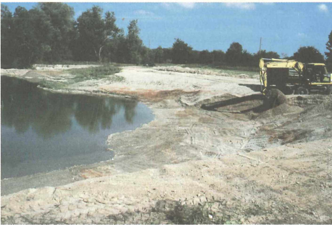
Foto 7: Biotopgestaltung im Südosten des NSG „Rosenau“. Nach Entfernung einer Hybridpappelreihe am steilen Südufer des Fischweihers wurde dieses mit dem Bagger flach ausgezogen (26.08.98), um breite, grundwassernahe Zonen zu schaffen, die von Arten der kalkreichen Sümpfe besiedelt werden können.
