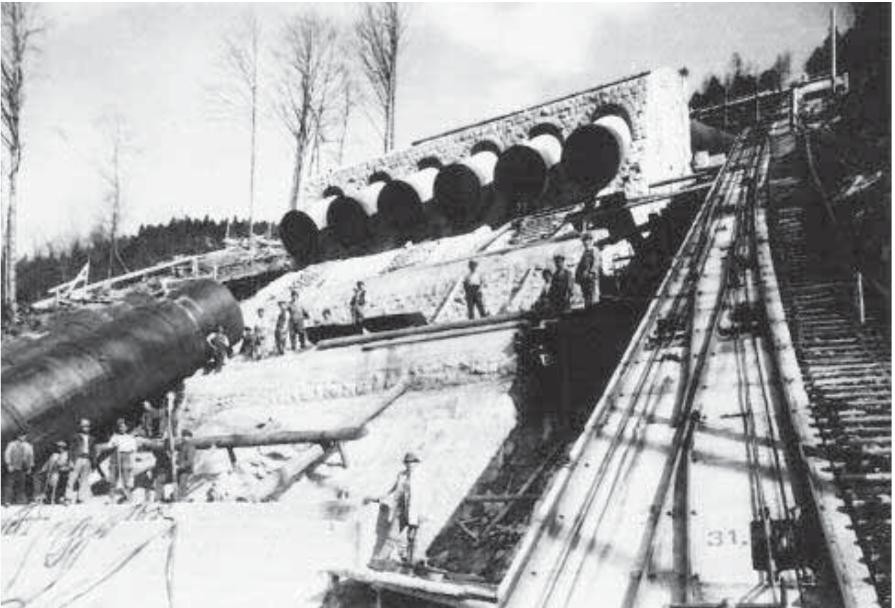
Abbildung 19: Wassermessversuche am Messsteig. [Aus: PLESSEN, M.-L. (1983): Die Isar. Ausstellung im Münchner Stadtmuseum vom 5. Mai bis 25. September 1983. – Heinrich Hugendubel Verlag, München, 373 S. (Mit freundlicher Genehmigung der Bayernwerk AG)]
