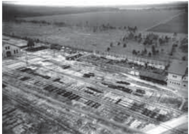
Abbildung 1: In den Jahren 1937/38 wurde das 1906 gegründete „Reisezugwagen-Ausbesserungswerk“ in München-Neuaubing (Vordergrund) durch ein Gleislager erweitert, wo Weichen montiert und gebrauchte Gleisteile zwischengelagert wurden. Die Abbildung zeigt den Zustand vor der Umwandlung, als die Fläche noch Teil der damals im Norden und Westen Münchens verbreiteten Kalkmagerrasen war (Foto: anonym).
