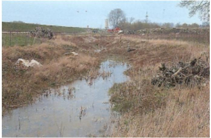
**Foto 17** (zu Kap. 4.2.1.1.4, 4.2.4.1): Gestaltungsvorbild eines Qualmwassergrabens an der Staustufe Vohburg/Donau: Unterschiedliche Uferausformung, Totholzablagung, landwärts abgerückt vom Dammfuß (Foto: SCHWAB 4/1992).
