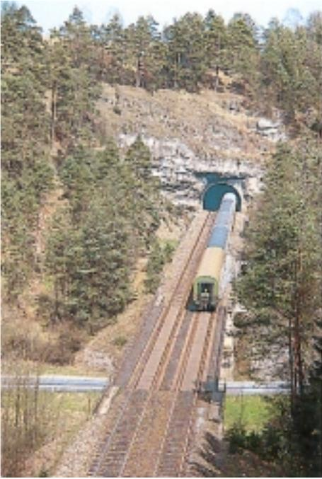
**Foto 9** (zu Kap. B 1.3.3.1, B 1.9.2, B 1.9.3): Typischer, das Landschaftsbild stark prägender Abschnitt der Pegnitztalbahn. Enges Aufeinanderfolgen von talquerender Brücke, Damm und Tunnel; Brückenkopf- Stützmauern und Tunnelportal sind aus dem anstehenden Weißen Jura gefertigt (Foto: SCHWAB 4/1992).
