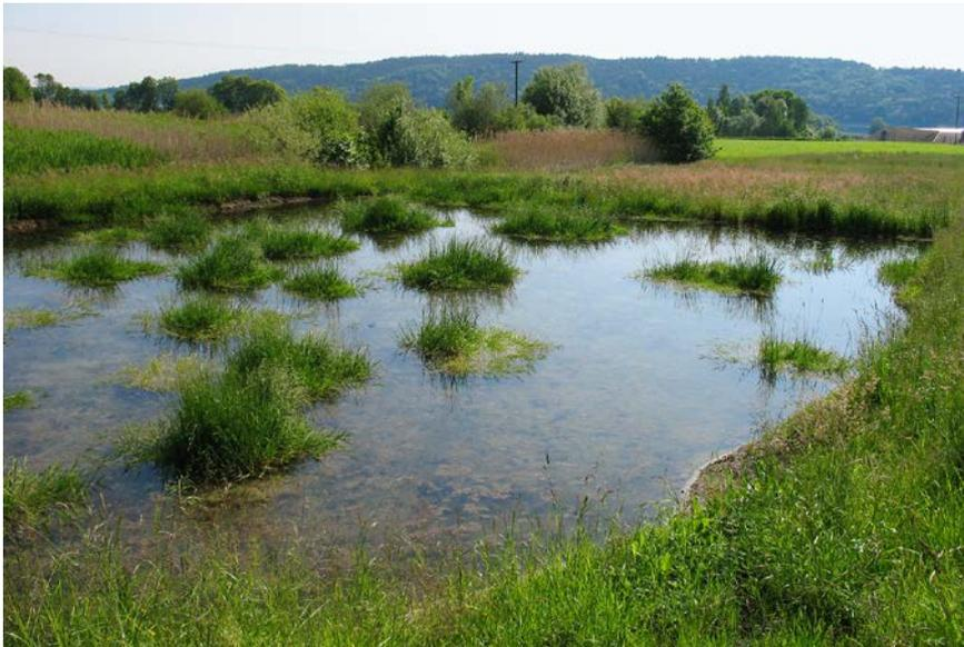
Abb. 7: Die eingestaute Feuchtfläche bei Schneidergröben im Einzugsgebiet des Tachinger Sees ist die Kombination aus einer „Feuchtfläche zum Rückhalt von oberflächigen Abschwemmungen“ – hier von Gülle bei intensiver Grünlandnutzung – und einer „Fläche mit Hangverrieselung“ (Fertigstellung 2015; Foto: Anton Lenz).
