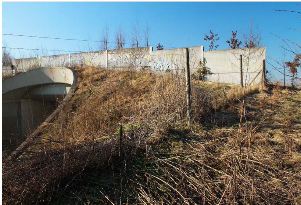
Schmale Grünbrücken wie in diesem Beispiel eignen sich häufig nicht für die Vernetzung anspruchsvoller Tierarten. Haselmäuse sind beispielsweise auf schützende Gehölzbestände angewiesen, um Querungshilfen nutzen zu können (Foto: Norbert Hirneisen/piclease).
