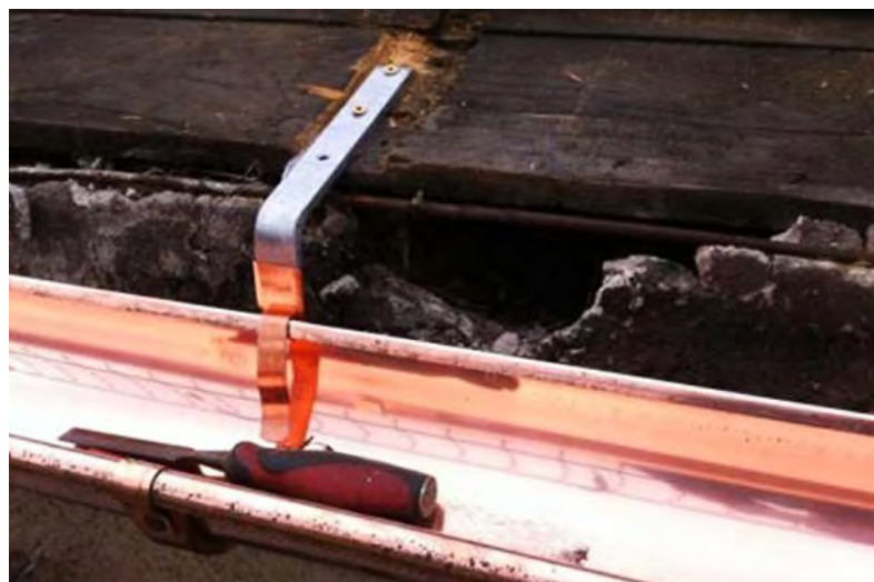
Abb. 3: Die große Ausbruchsstelle nutzen Mauersegler, um in den Traufkasten zu gelangen; bautechnisch sind solch große Ausbrüche ein Problem, da Feuchtigkeit eindringen kann.
