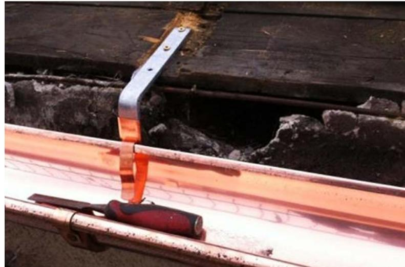
Abb. 3: Die große Ausbruchstelle nutzen Mauersegler, um in den Traufkasten zu gelangen; bautechnisch sind solch große Ausbrüche ein Problem, da Feuchtigkeit eindringen kann.
