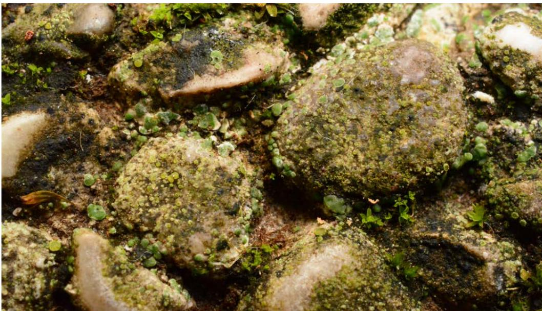
**Abbildung 10:** Der reliefreiche Waschbeton bietet verschiedenen Flechten und Moosen einen Lebensraum. Nacktes Gestein sieht man nur auf den durch Tritt beeinflussten Gipfeln, die tiefer liegenden Kiesel, die Flanken und Täler sind vollständig bewachsen. Erkennbar sind *Caloplaca holocarpa* (gelbgrüne Fruchtkörper), *Aspicilia contorta* (grüne Schuppen), *Verrucaria nigrescens* (schwarze Flecken) und am oberen Bildrand apokarpe Kleinmoose (*Syntrichia ruralis*).
