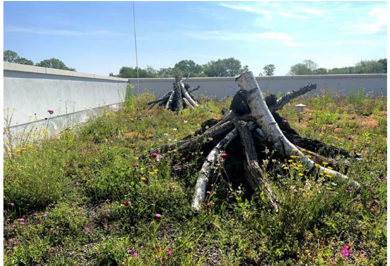
Abbildung 3: Gründächer mit Totholzstrukturen, Wiesenansaat und Pflanzen der Gattung Sedum
