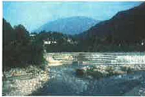
Triftwehr in Bad Reichenhall
