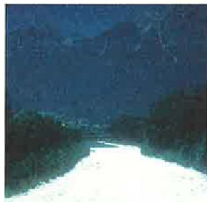
Regulierte Saalach bei der Lütjpolzbrücke in Bad Reichenhall ohne Restwasser im Gewässer
