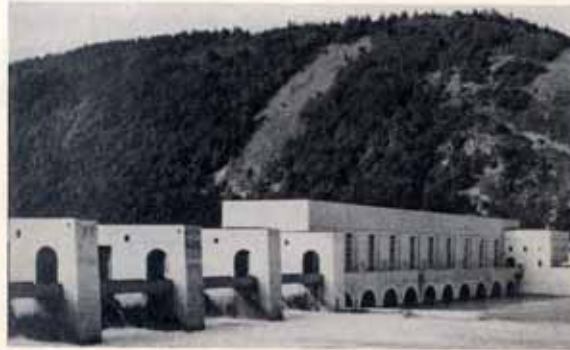
Kraftwerk Jochenstein in der Donau auf der bayerisch-österreichischen Grenze (aus: Seifert, A. (1962): Ein Leben für die Landschaft)
