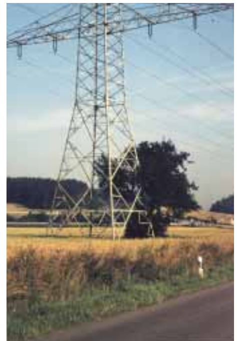
Foto 20: (zu Kap. 4.2.2.1): Bei Regenstau/R: Schon ein Mastfußbaum vermag zur Milderung der optischen Störfunktion eines Mastes beizutragen. Im vorliegenden Beispiel handelt es sich um einen wertvollen Ansatz, der allerdings durch weitere Bepflanzung noch optimiert werden könnte (Foto: RINGLER)
