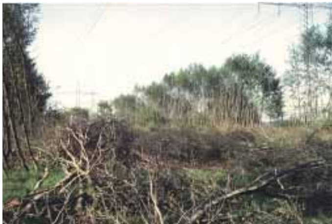
Foto 16: (zu Kap. 3.1 ): Materialverwertung: Geschnittene Bäume und Sträucher werden als kleine Teile belassen und ohne weitere Zerkleinerung über den gesamten Trassenverlauf verteilt (Foto: KILLER).
