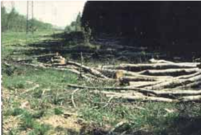
Foto 15: (zu Kap. 3.1 ): Materialverwertung: Geschnittene Bäume und Sträucher werden in ein bis zwei Meter lange Teile zerkleinert und am Rande der Trasse aufgeschichtet (Foto: KILLER).
