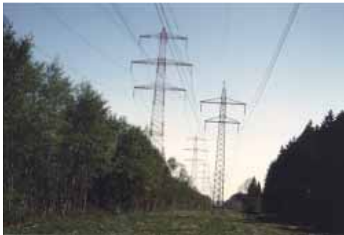
Foto 8: (zu Kap. 2.1.2.4.2. 1): Niederwaldartige Vegetation dient als Sichtblende in Form von streifenartigen Gehölzen im Vergleich zum Kahlschlag. Hier: Erlenniederwald auf Doppelschneise bei Oberbrunn/STA (Foto: KILLER).
