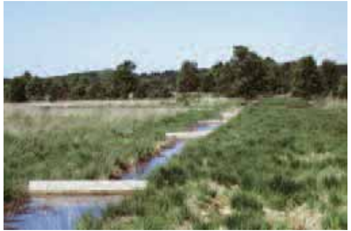
Foto 1 Gestaffelte Staus aus Planboardplatten im Dosenmoor, Schleswig-Holstein
